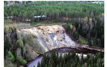
Pågående ras Foto: Örjan Hansson
